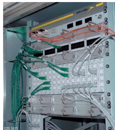
Etagenrack, bestückt mit Kupfer- und Fiber-Optic-Komponenten von R&M.
